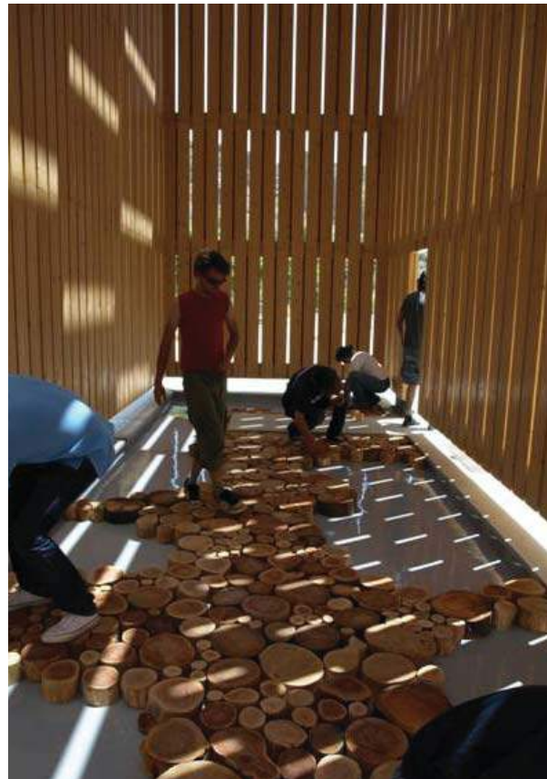
Imágenes del montaje del suelo de troncos en Museo del Agua, Lanjarón Fuente: Juan Domingo Santos
