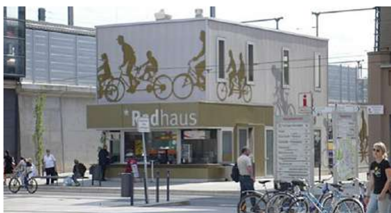
Ilustración 6. Centro de la Bicicleta en la estación de ferrocarril de Erfurg.
