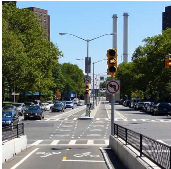
Sands Street. Reducción del número de carriles para crear una vía ciclista en la mediana con señalización en un tramo y con protección en otro.
