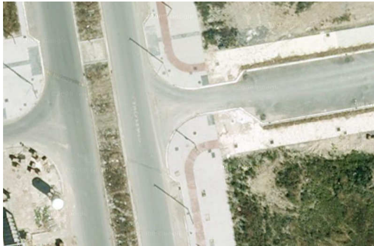
Paso ciclista con retranqueo excesivo (cruce Boulevard de Salburua y calle Varsovia)
