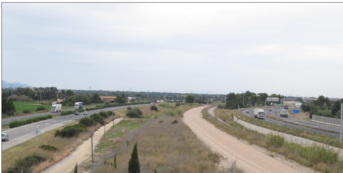
Figura 14. Replicació en paral·lel d'infraestructures d'alta capacitat viària
