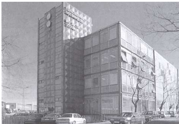
Oficinas de esmaltaciones San Ignacio, 1964. Arquitectos: Enrique Miramón y Ramón de Aspiazu. (Guía de Arquitectura de Vitoria-Gasteiz)
