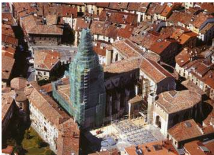
La catedral vieja de Santa María en proceso de rehabilitación
