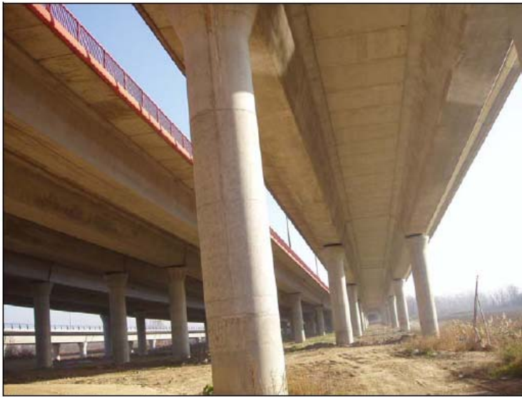
El impacto de las grandes infraestructuras viarias como la M45 y la M50 además de fragmentar el territorio, suponen una barrera a la accesibilidad sostenible.
