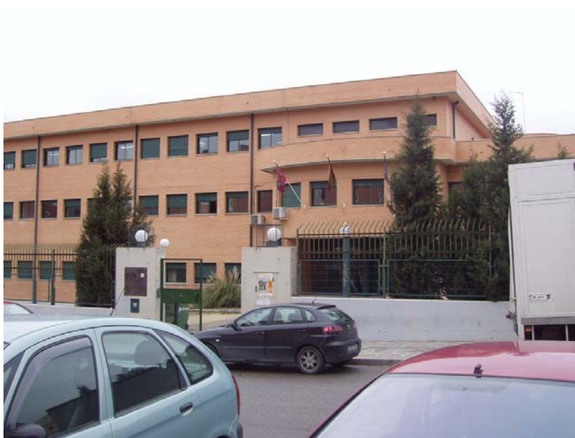
Instalaciones del Instituto Ferran Clua, en la calle Jean Paul Sastre. Presencia importante de coches estacionados en la entrada.
