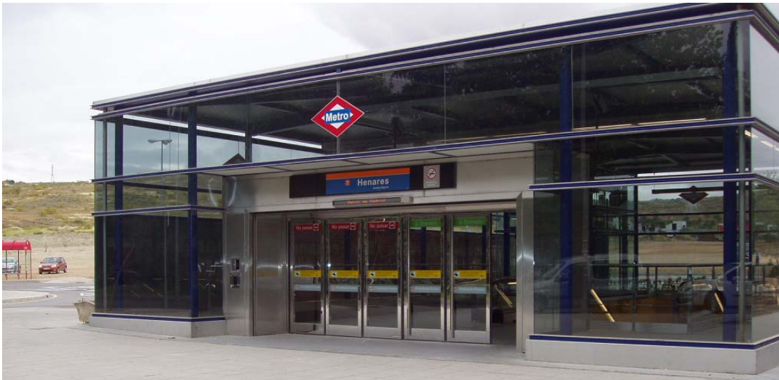
Estación de "Henares"
