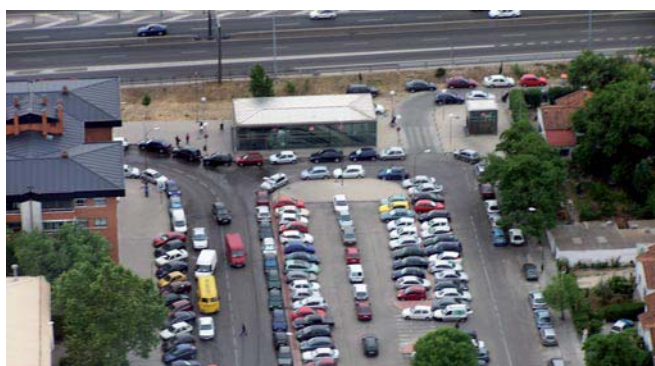
Fig. 10. Estación de metro Aviación Española, en la línea 10, en el borde de la autovía de acceso A-5.
