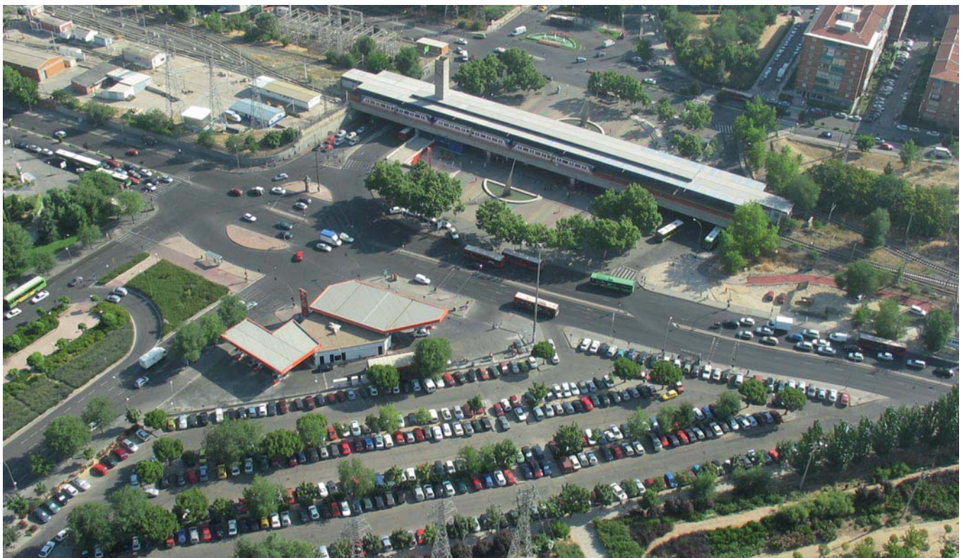
Fig. 12. Panorámica de la Estación de Aluche, uno de los primeros intercambiadores de Madrid.
