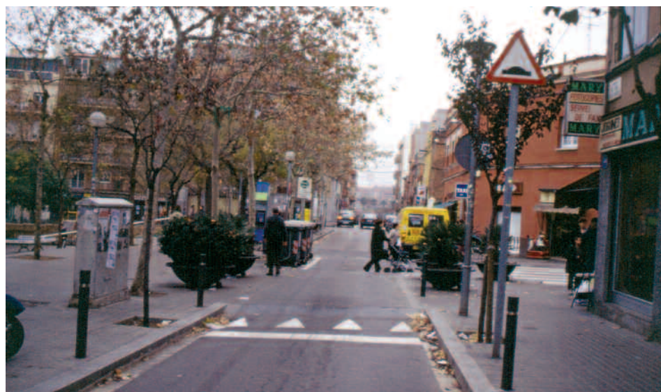
◀ Exemple de “passos de vianant elevats”
