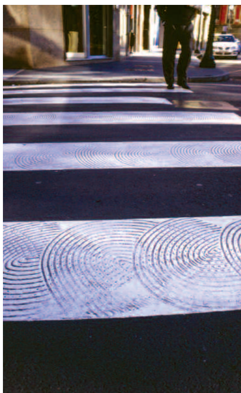
Pas de vianants amb pintura antilliscant ▶
