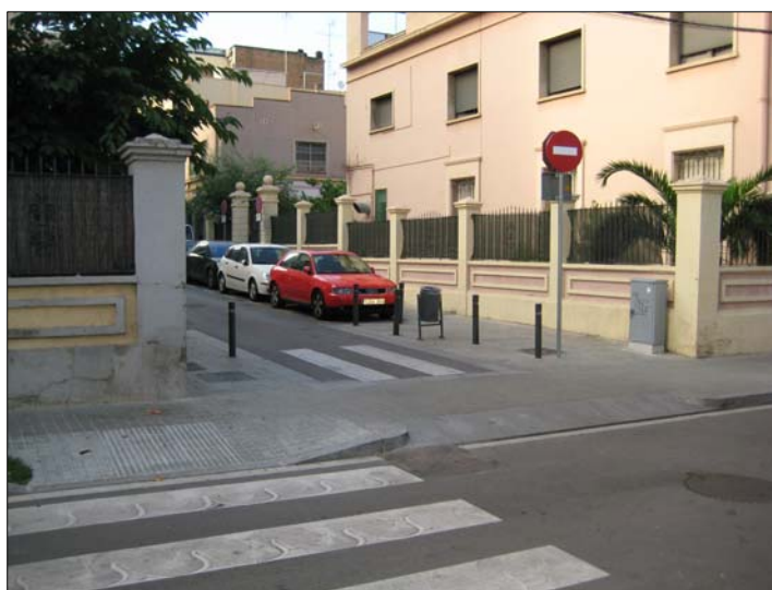
Mostra de la contradicció entre el material de vorera emprat a la intersecció i el pas de vianants ubicat sobre l'asfalt de la plataforma única i fora de la trajectòria dels vianants de la via convencional.
