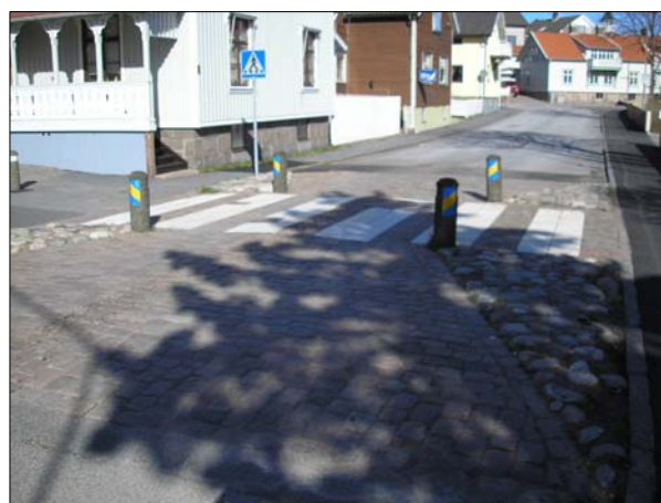
Estretament puntual de la calçada a través d'e l'arbrat i els escocells (esquerra) i estretament de la calçada coincidint amb un pas per a vianants en via de doble sentit de circulació motoritzada (dreta).
