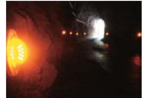
• Balizas de guiado en el túnel de una vía ciclista (Leitzarain).
