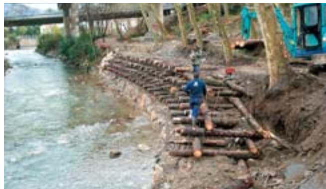
• Construcción de un emparrillado de madera para una vía ciclista (Errenteria).
