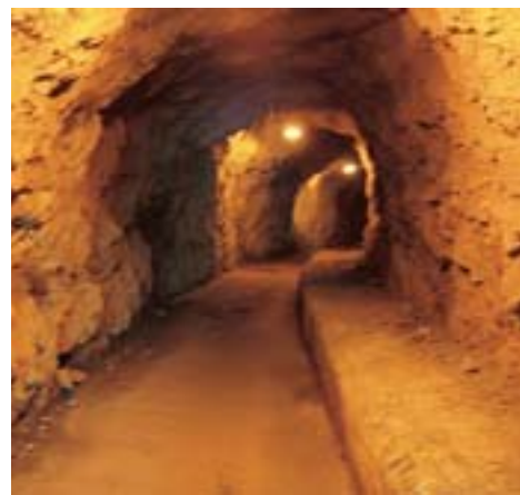
• Túnel iluminado en vía ciclista (Oiartzun).
