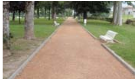
• Firme de grava Miranda estabilizada (Santuario de Loiola, Azpeitia).
