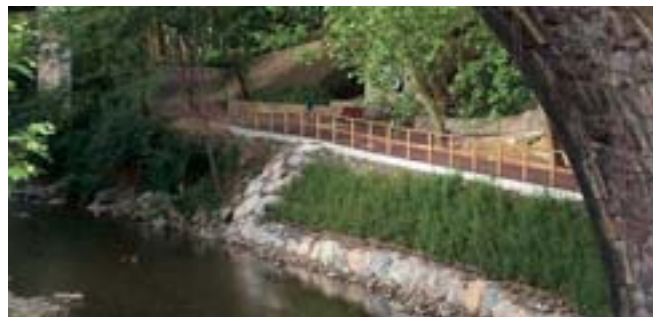
• Aspecto del emparrillado de madera tres meses después de su construcción (Errenteria).
