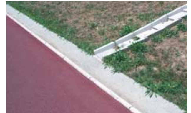
• Cuneta de hormigón y bajante de talud junto a una vía ciclista.
