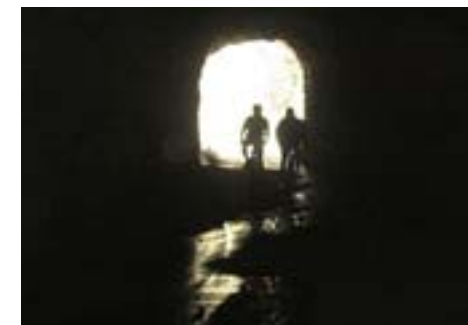
• Túnel en vía ciclista (Leitzaran).
