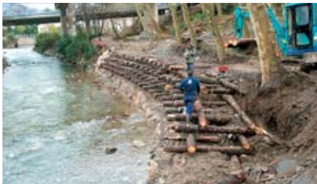
• Bizikleta bide baterako egurrezko parriladura baten eraikuntza (Errenteria)
