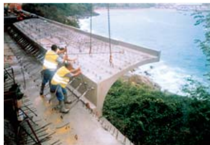
• Aurrefabrikatutako piezetako baten ezarpena
