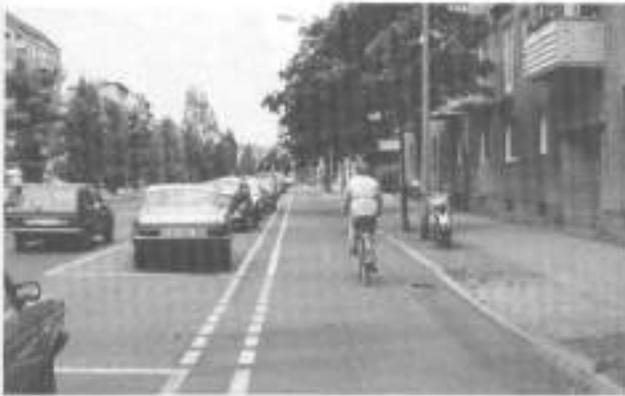
Pista-bici en Berlín resultante de una modificación de la sección original y protegida del tráfico motorizado mediante franja de aparcamiento.
