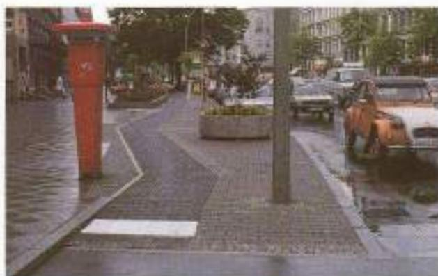
Tratamiento de pavimentación, señalización y trazado para el segmento final de una acera-bici en Berlín.
