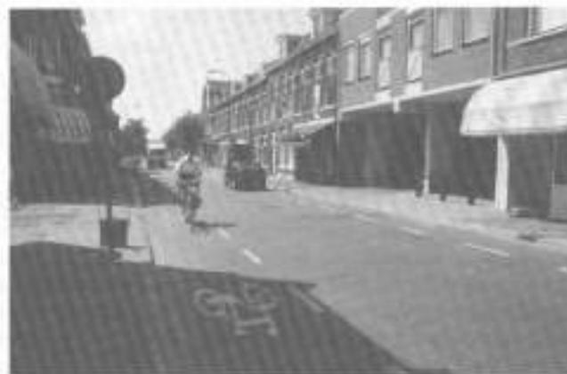
*Camió-bici y sección central bidireccional para los vehículos motorizados en Delft (Holanda).*
