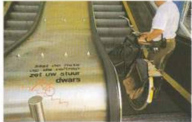
Escalera mecánica diseñada para su utilización por ciclistas en un intercambiador de transporte holandés.
