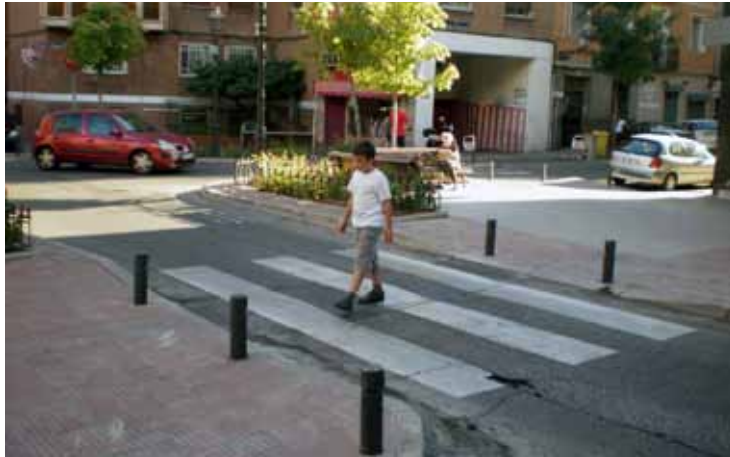
Ampliación de aceras para facilitar y dar seguridad al cruce (Madrid)
