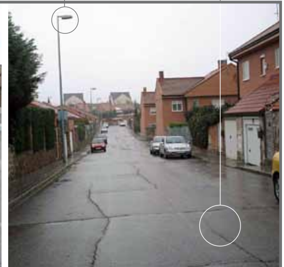
iluminación solo para la calzada
