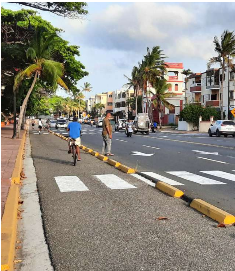
Imagen III. 24. Ciclovía segregada en Puerto Plata
