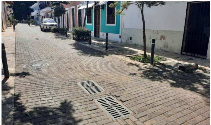
Imagen IV. 33. Drenaje central en calle adoquinada
