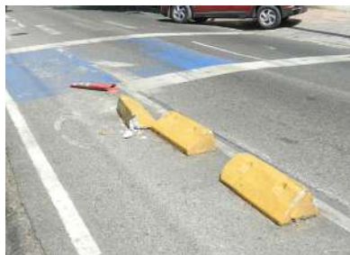
Imagen IV. 61. El mantenimiento de los separadores como criterio a considerar
