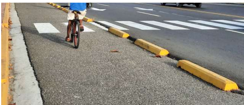
Imagen IV. 24. Pavimento bituminoso en ciclo vía en Santo Domingo
