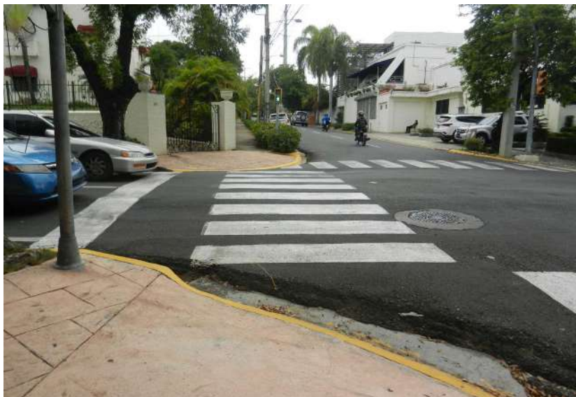
Imagen I. 10. Contén y acumulación de capas asfálticas en Santo Domingo
