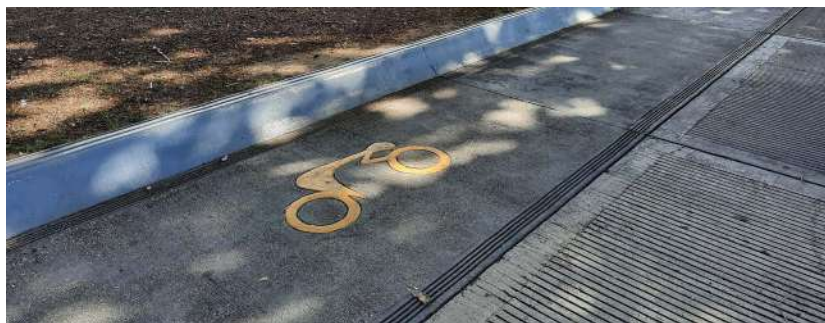
Imagen IV. 25. Pavimento de hormigón en ciclo vía en Santo Domingo
