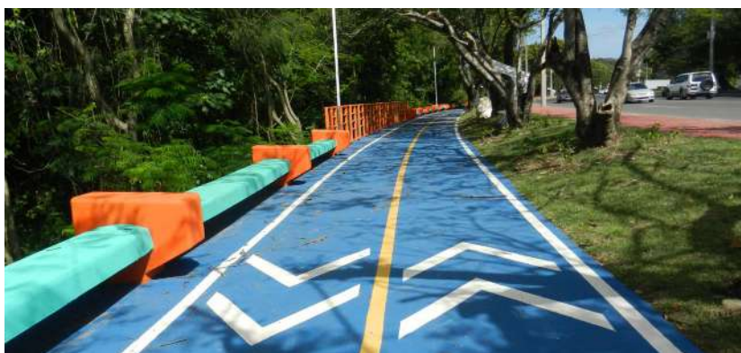
Imagen IV. 60. Vallas de hormigón y metálica de delimitación de la ciclovía en Santiago de los Caballeros
